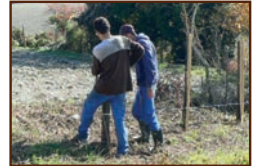
Pose de clôture
