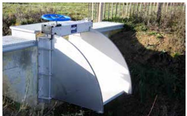
Par ailleurs, des travaux visaient à équiper les différents ouvrages hydrauliques du site par des vannes, grilles et caillebotis ont été réalisés. Ils permettent une meilleure gestion hydraulique dans le cadre de l'alimentation en eau des bassins, de l'étang principal et du marais.
