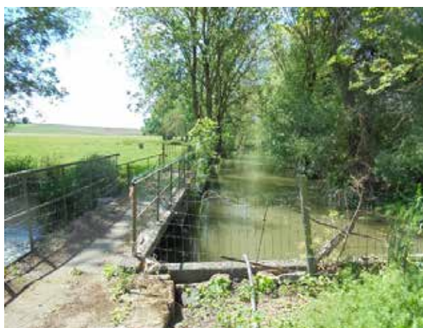
Seuil de l'ancien moulin, avant travaux (S.Manse)
