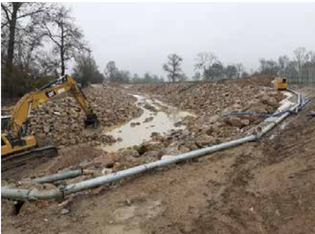
Terrassements - Octobre 2020 (CD37)
