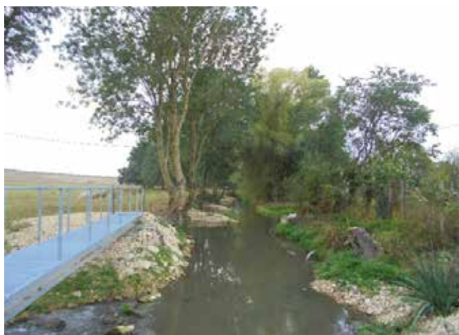
Seuil de l'ancien moulin, après travaux (S.Manse)
