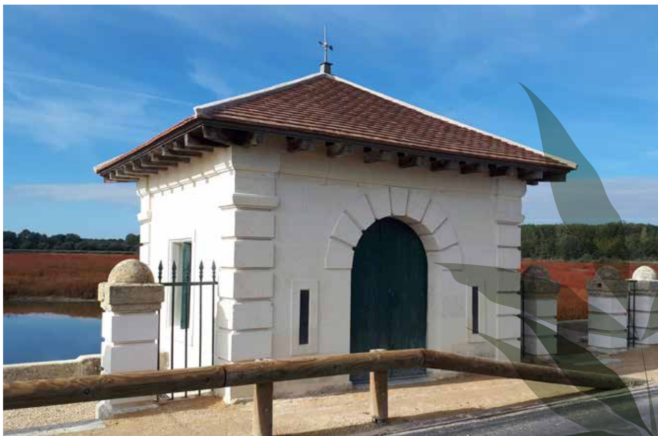
La loge de la digue restaurée
