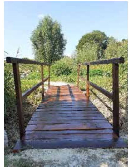
La passerelle restaurée, poncée et lasurée
