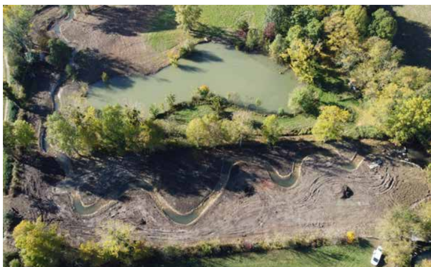
Aménagement de la rivière de contournement du moulin Foulon (CCLST)
