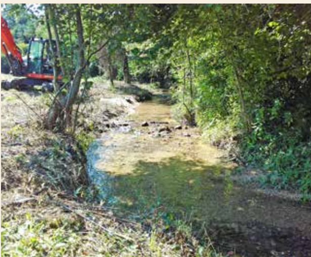
Recharge granulométrique sur la Duire (CC GCPR)
