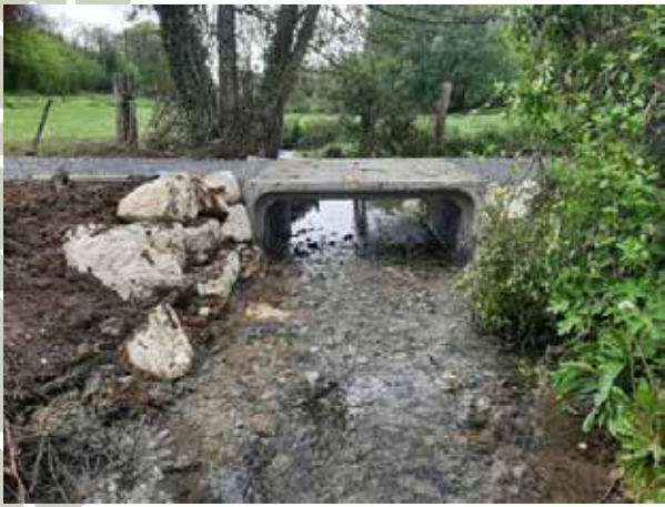
Remplacement de buses par un pont cadre (ANVAL)
